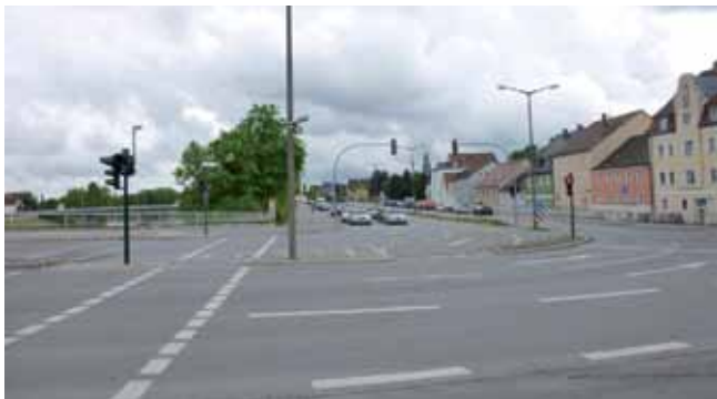
Rückbau der Bayerwaldstraße!
